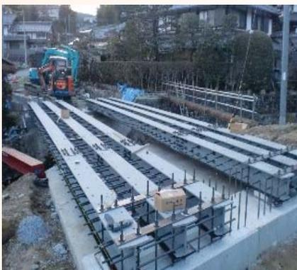
桁下面型枠設置状況
