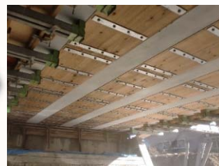
桁下面型枠設置状況
