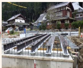
H鋼桁架設状況
