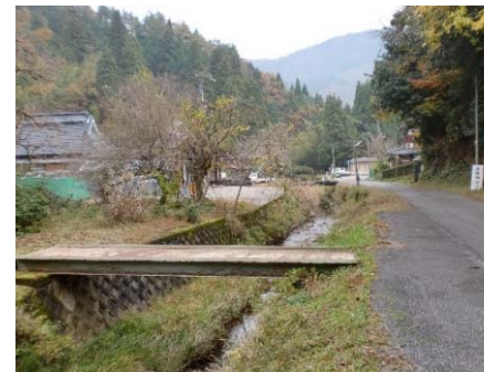
施工前(Before) 側面
