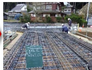
桁上面鉄筋組立状況
