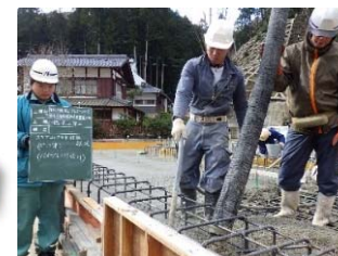
橋体Co打設状況
