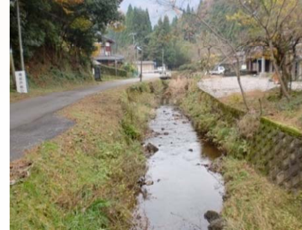
施工前(Before) 正面
