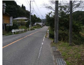
施工前(Before) 正面
