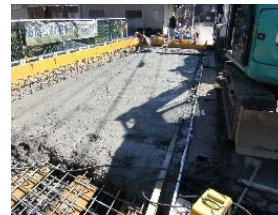
橋体Co打設状況
