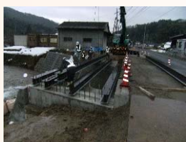
H鋼桁架設状況
