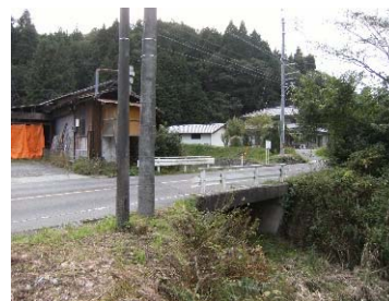
施工前(Before) 側面
