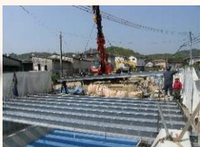
桁下面型枠設置状況
