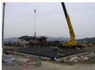
桁上面鉄筋組立状況
