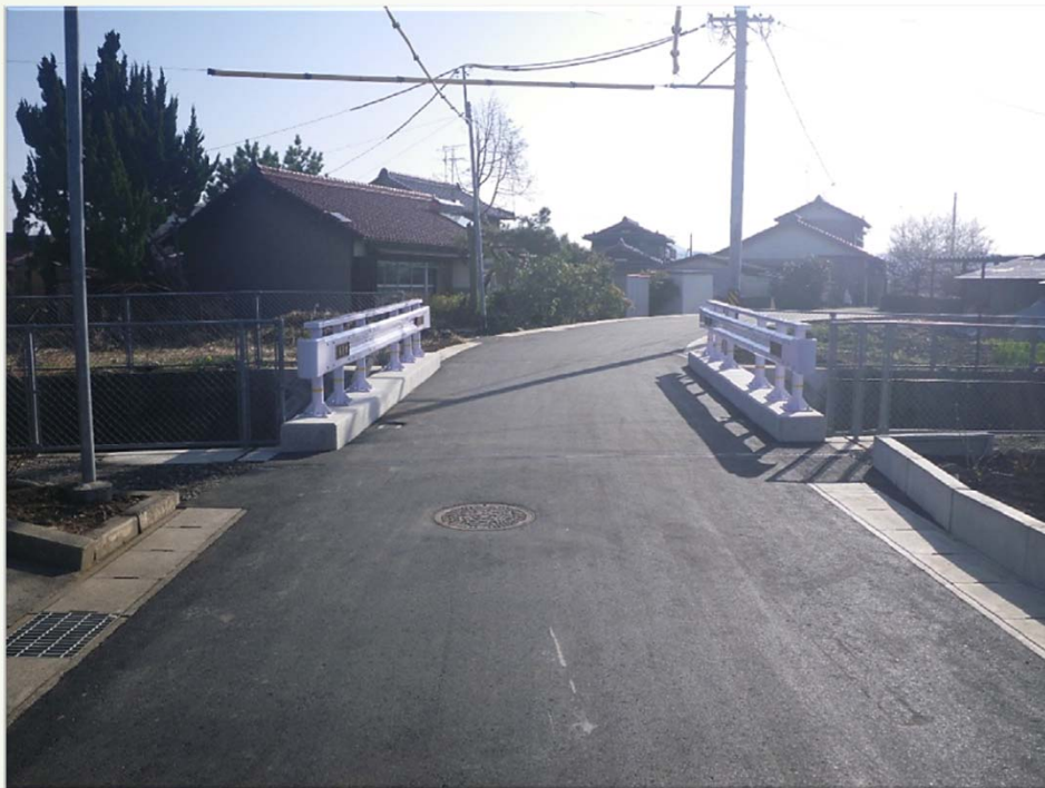
完成(After) 正面
