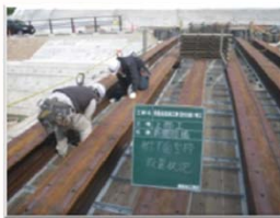
桁下面型枠設置状況
