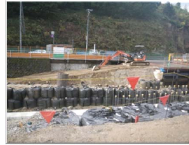
施工前(Before) 正面
