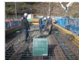
橋体Co打設状況
