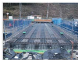
桁上面鉄筋組立状況
