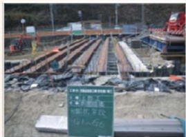
H鋼桁架設状況
