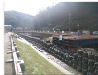
施工前(Before) 側面
