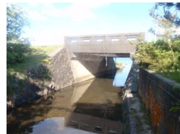
施工前(Before) 側面
