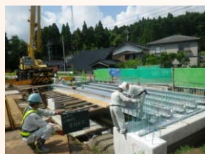
H鋼桁架設状況
