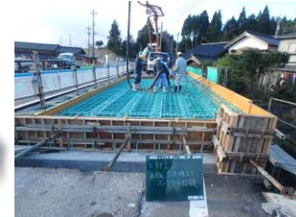
橋体Co打設状況
