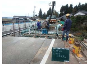
桁上面鉄筋組立状況
