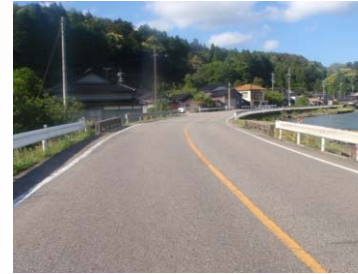
施工前(Before) 正面
