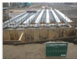
桁上面鉄筋組立状況
