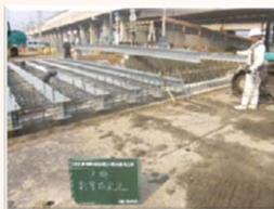
桁下面型枠設置状況
