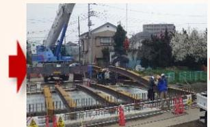
桁下面型枠設置状況
