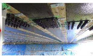
桁上面鉄筋組立状況
