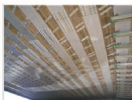
桁下面型枠設置状況
