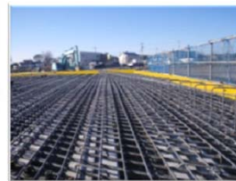
桁上面鉄筋組立状況
