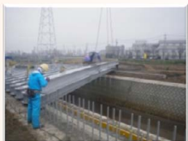
H鋼桁架設状況
