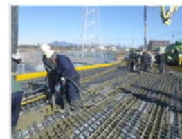
橋体Co打設状況
