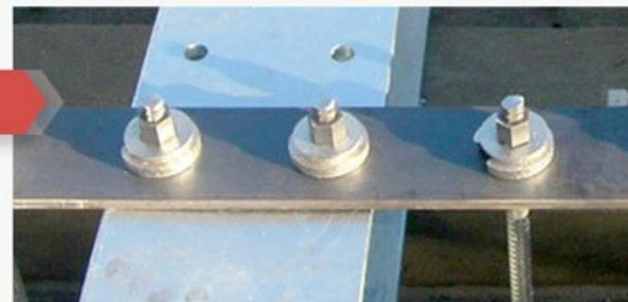
下部工施工時に上下部連結金物を使用することにより、主鉄筋配置精度を確実なものにする
