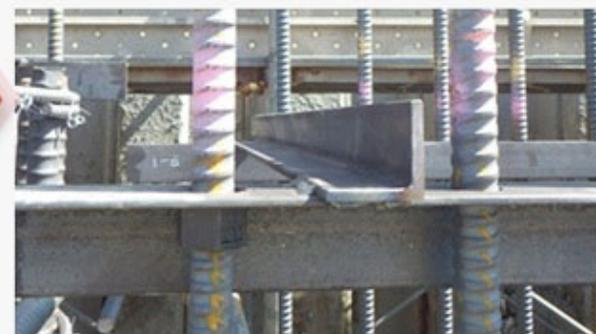
鉄筋支持金物は必ず所定の位置に配置し、正確に配筋を行う
