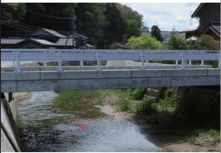
支間中央部（損傷なし）
