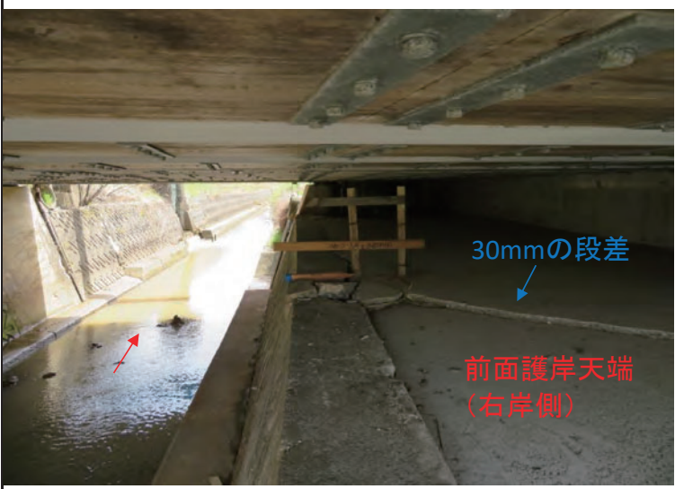
右岸側前面護岸部(最大30mmの沈下)
