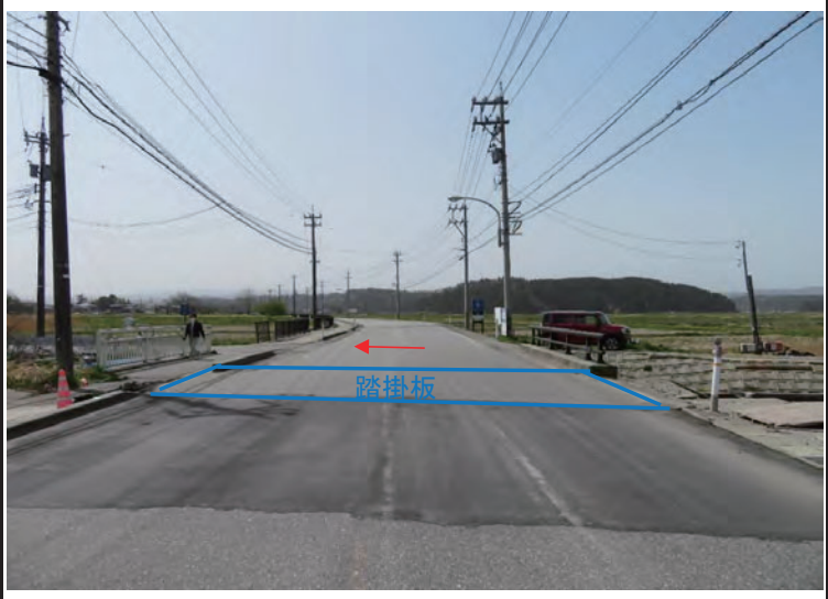
左岸側橋台背面土工部(最大40mmの段差) ※踏掛板あり
