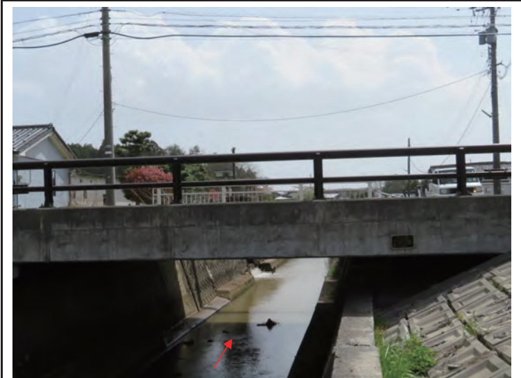
支間中央部(損傷なし)
