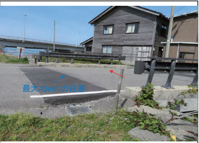
左岸側橋台背面土工部(最大40mmの段差)
