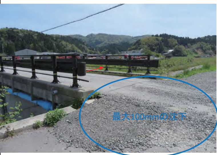
右岸側橋台背面土工部(最大100mmの沈下)
