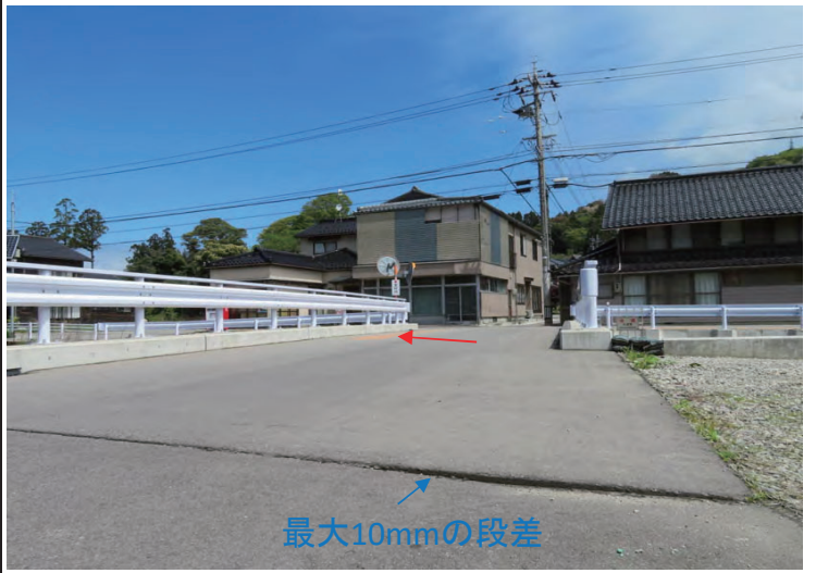
左岸側橋台背面土工部（最大10mmの段差）
