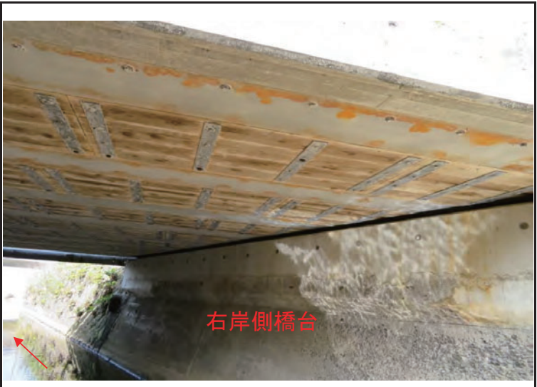
右岸側橋台(損傷なし)
