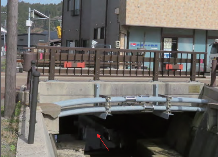
支間中央部(損傷なし)
