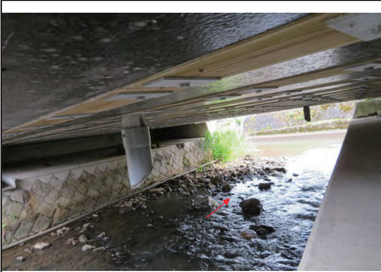
桁下面(損傷なし)
