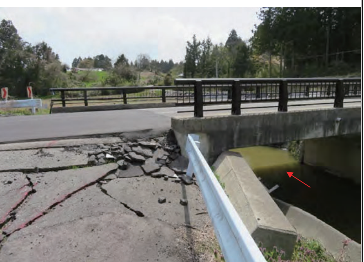
左岸上流側取付道路部(地盤沈下によるAs損傷)
