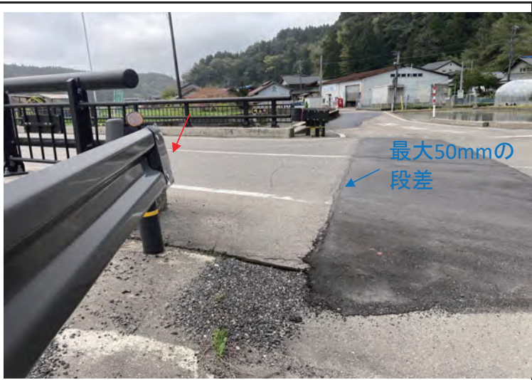
左岸側橋台背面土工部(最大50mmの段差)
