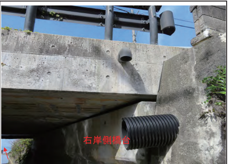
右岸側橋台(損傷なし)
