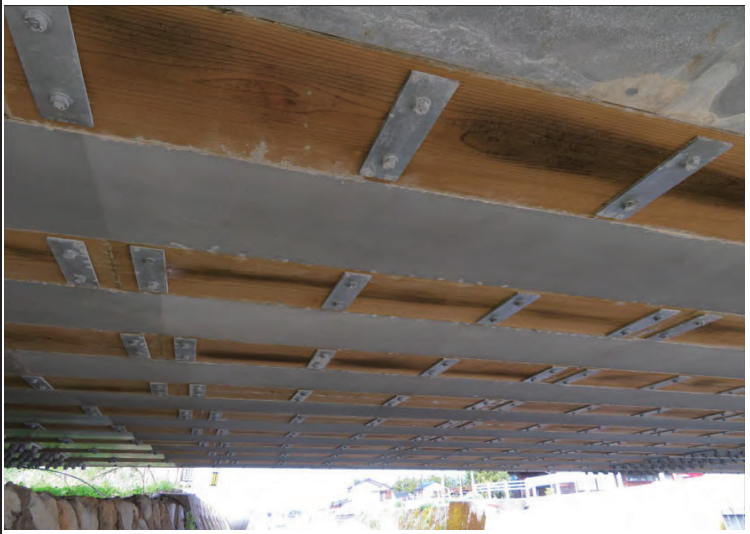
桁下面（損傷なし）
