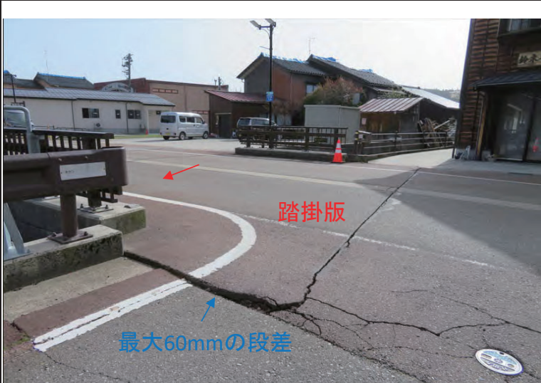
左岸側橋台背面踏掛版横(最大60mmの段差)
