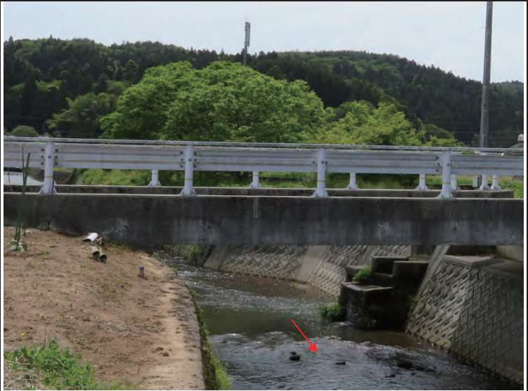
支間中央部(損傷なし)
