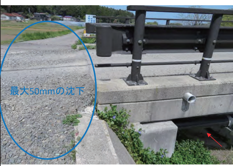
左岸側橋台背面土工部(最大50mmの沈下)
