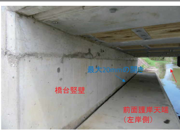
左岸側前面護岸部(最大20mmの開き)
