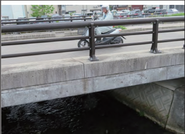
支間中央部(損傷なし)
