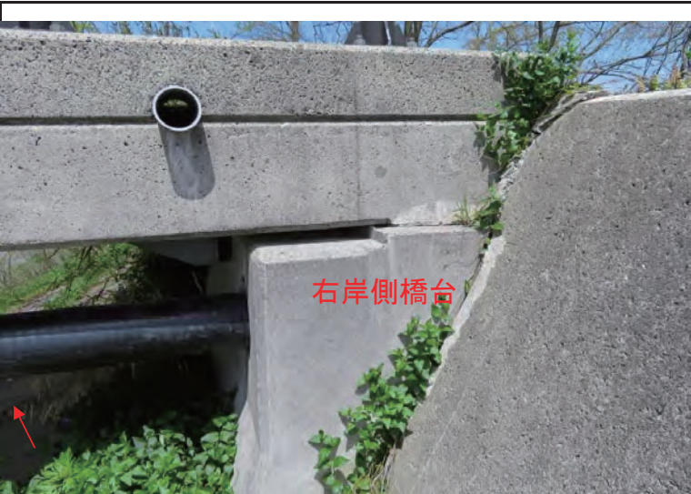
支承部(損傷なし)
