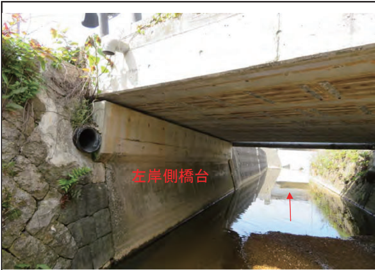
左岸側橋台(損傷なし)
