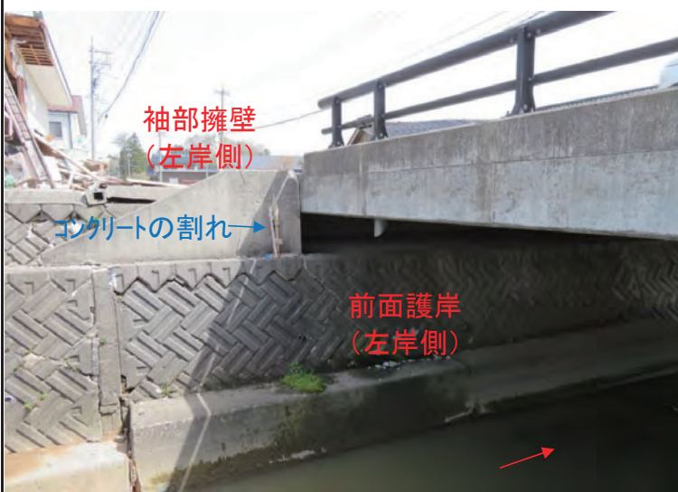
左岸側前面護岸・袖部擁壁部(ひびわれ有り)
