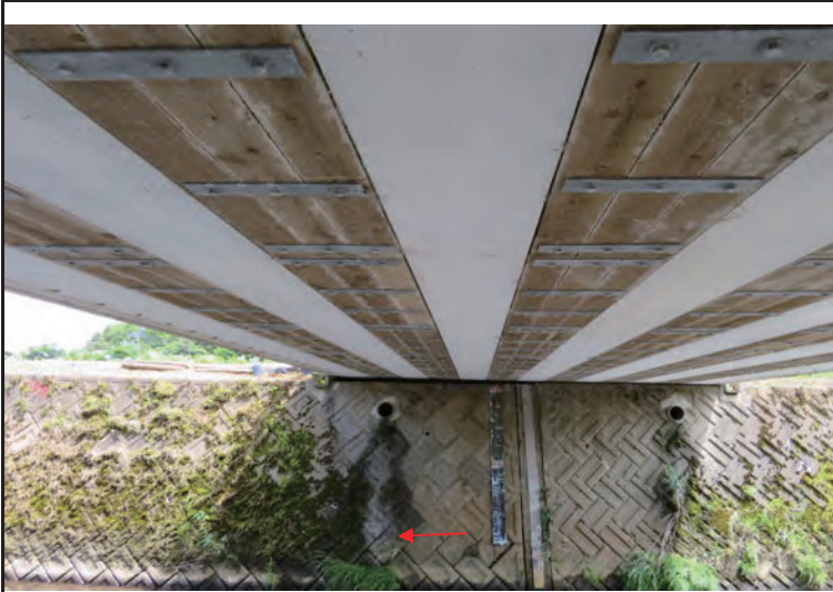
桁下面(損傷なし)
