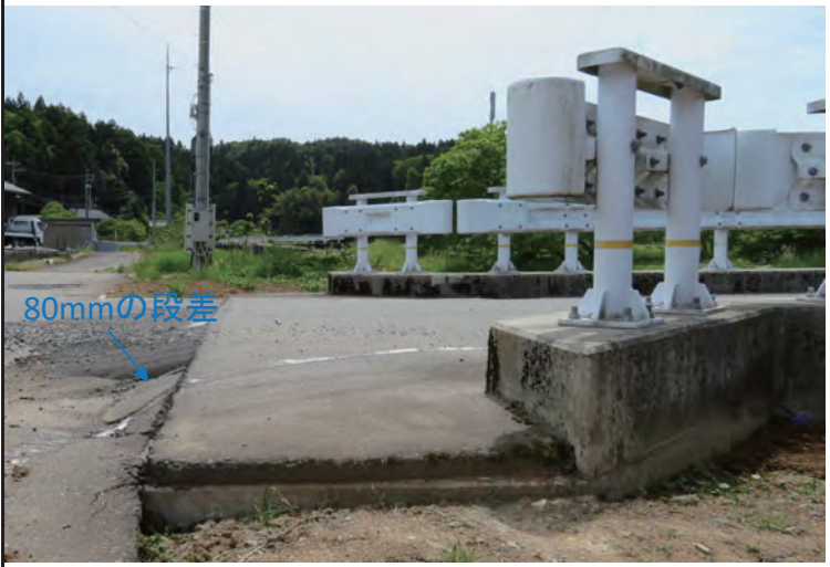
右岸側橋台背面土工部(最大80mmの段差)
