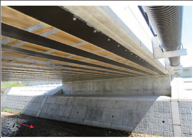
桁下面(損傷なし)
