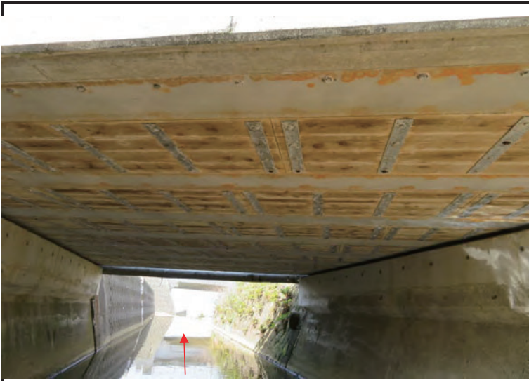
桁下面(損傷なし)
