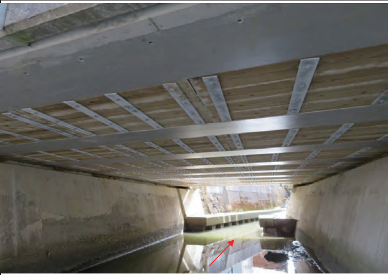
桁下面(損傷なし)
