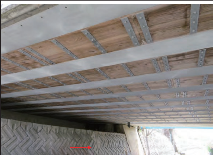
桁下面(損傷なし)
