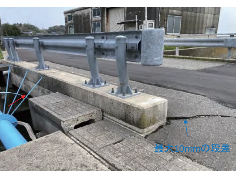
右岸側橋台背面土工部(最大10mmの段差)
