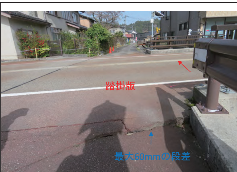
左岸側橋台背面踏掛版横(最大60mmの段差)
