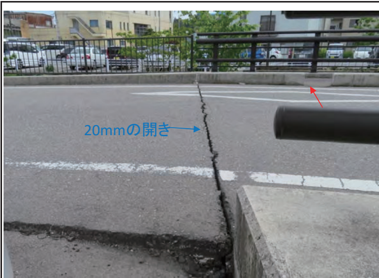
左岸側橋台背面土工部(最大20mmの開き)
