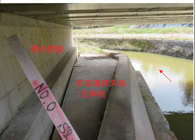
前面護岸部(最大30mmの開き)
