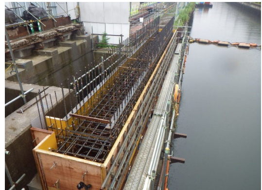
図 3.3.6 下部エコンクリート打設前状況
