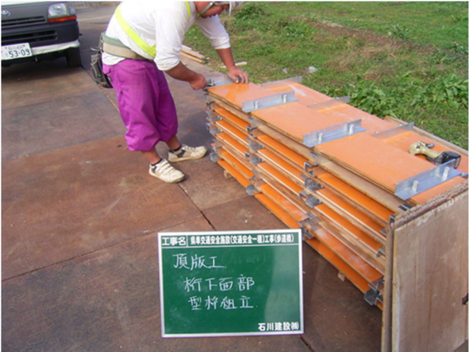
桁下面型枠組立状況（撤去型枠：合板）
