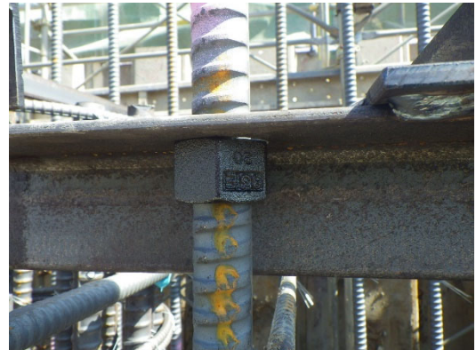
図 3.3.4 鉄筋支持金物固定ナット
