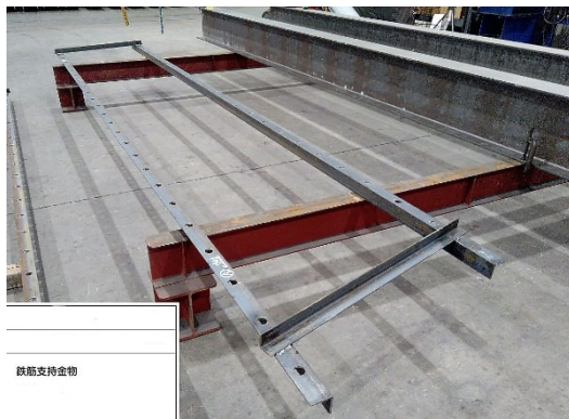
図 3.3.3 鉄筋支持金物
