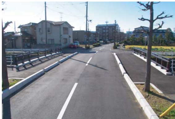
ジョイントレス構造施工例
